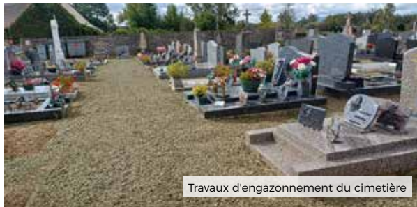
Travaux d'engazonnement du cimetière
